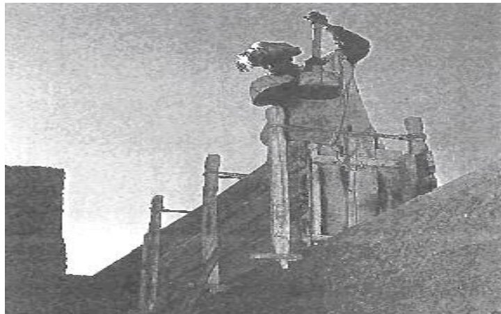
ج - عملية دك التربة في التابوت صورة (2) عمليات بناء الجدار بالتابوت
